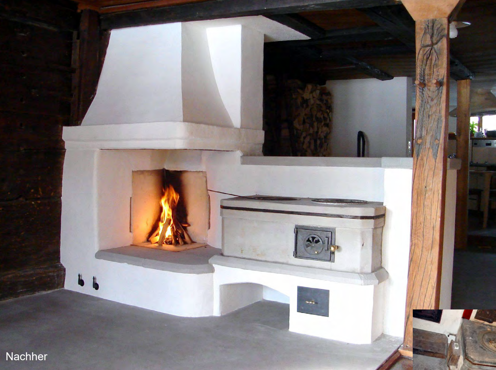
Aufbau einer Feuer- Grill- und Kochstelle, Restauration eines antiken Sandsteinherdes
