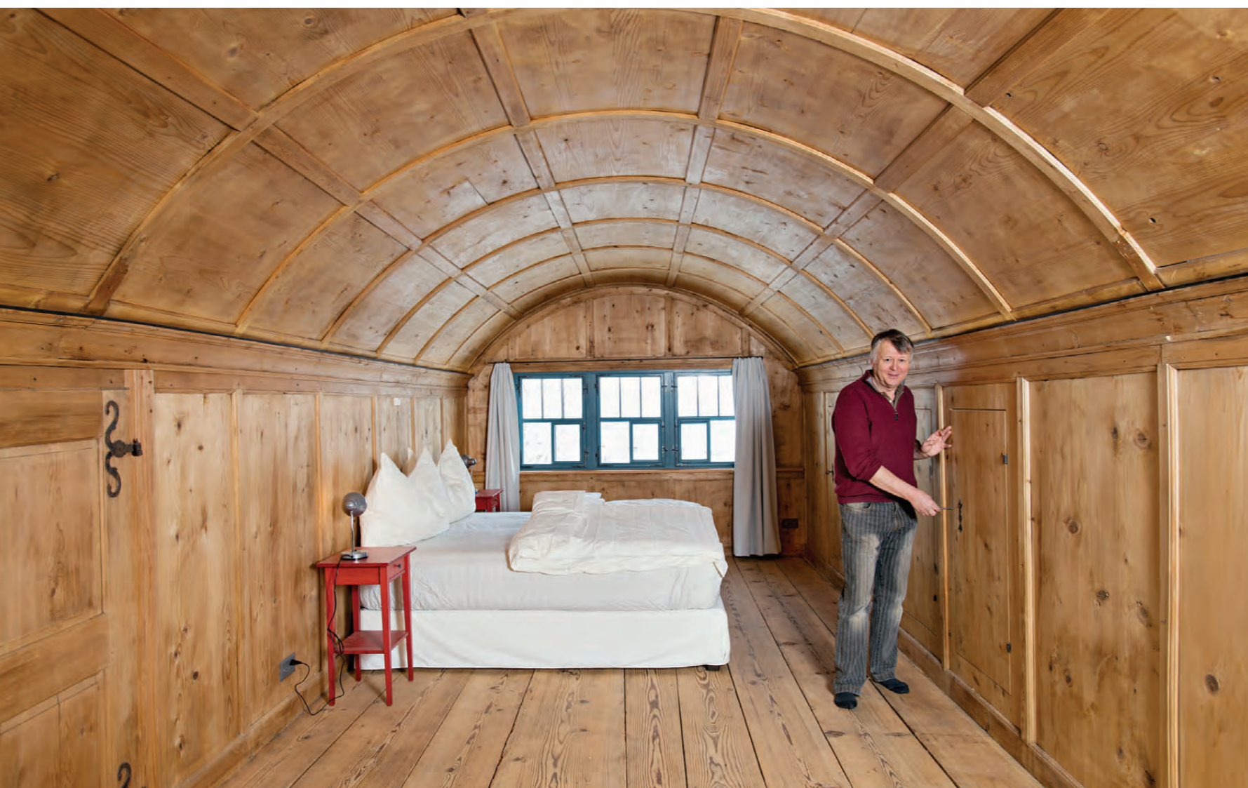
Die Holzkassettendecke, die ohne einen einzigen Nagel befestigt wurde, begeistert Bauexperte Paul Rutz.
