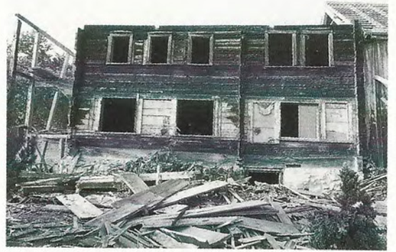
Haus in Allenwinden ob Rüeterswil während der Zerlegung 1990.
