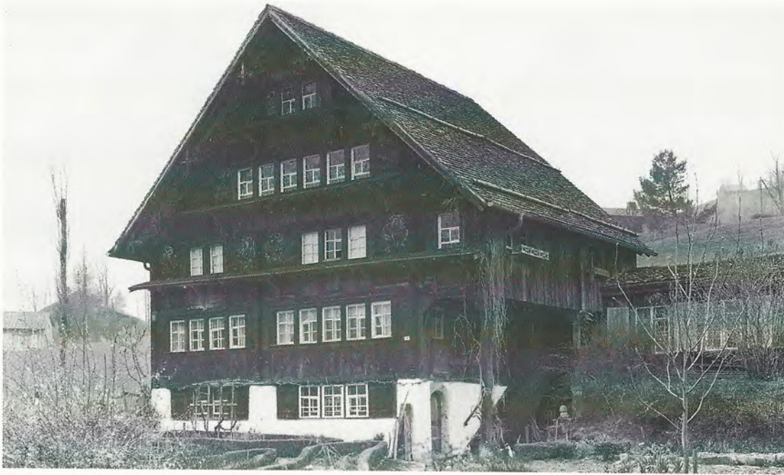
Das versetzte Haus zum Acker in Ebnet, Ackerhusweg 16. Seit 1952 Heimatmuseum der Albert Edelmänn-Stiftung. Zustand 1967.
