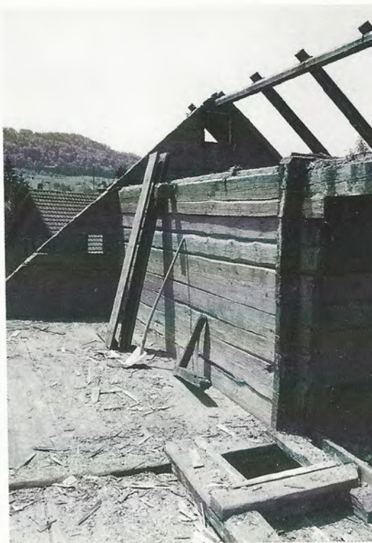
Während des Abbruchs 1994. Das Firstkammerlein ist ausgepackt.
