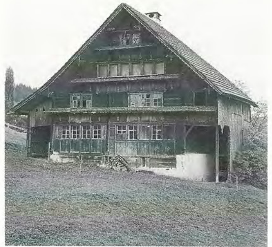
Oben: Haus in Füberg Oberhelfenschwil, erhöht 1752. Zustand 1949. – Unten das versetzte Haus während des Wiederaufbaus im «Acker» nordwestlich von Ebnat, 1950.
