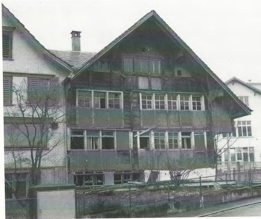
Flawil, Müligass 28. Ehemaliger Strickbau von 1636, abgebrochen 1994. Zur Zeit eingelagert und für die Versetzung nach Niederstetten Uzwil bestimmt.
