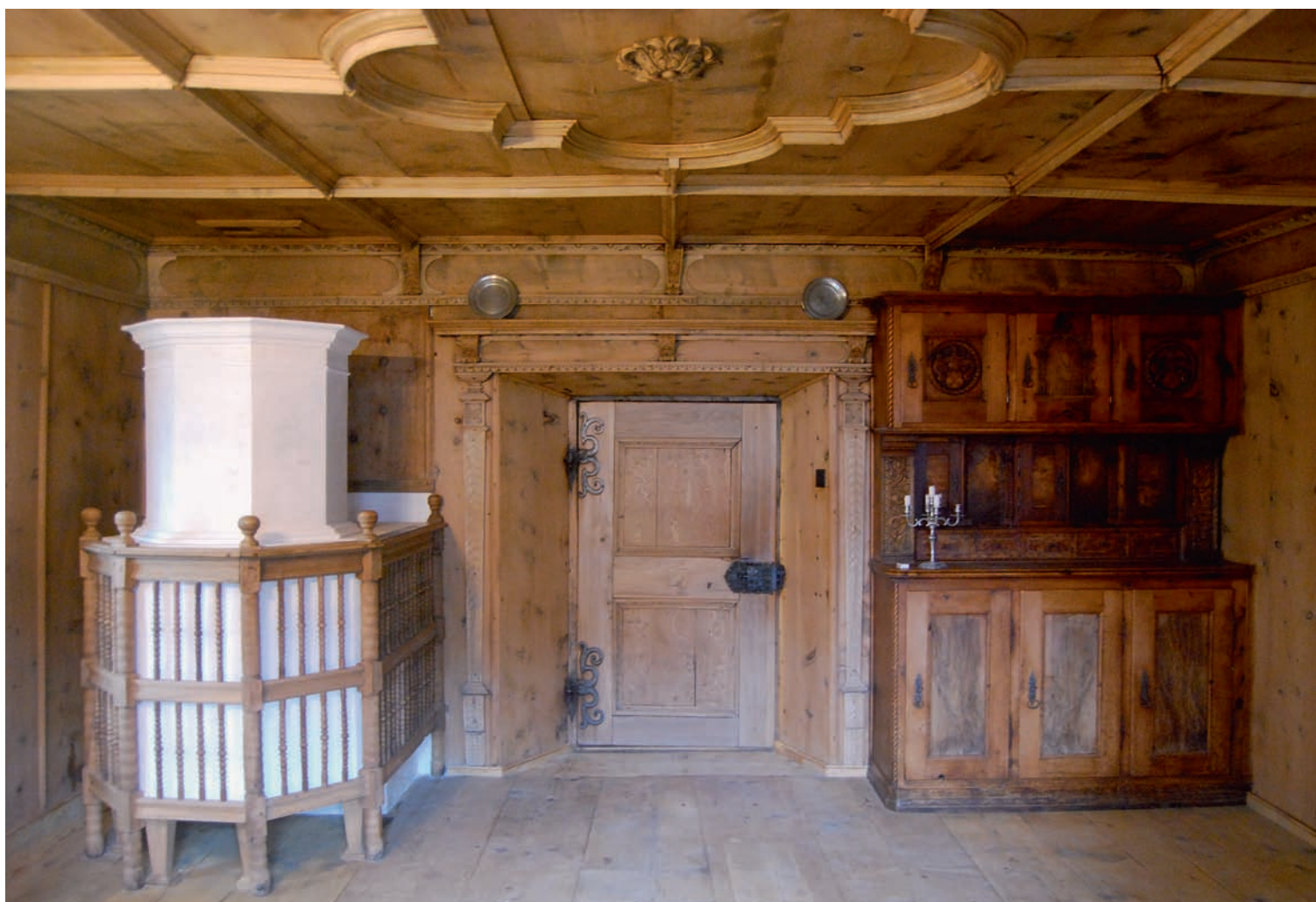
Le poêle à l'achèvement de sa construction. La pièce possède un lambrisage de bois d'arole datant de 1708.
