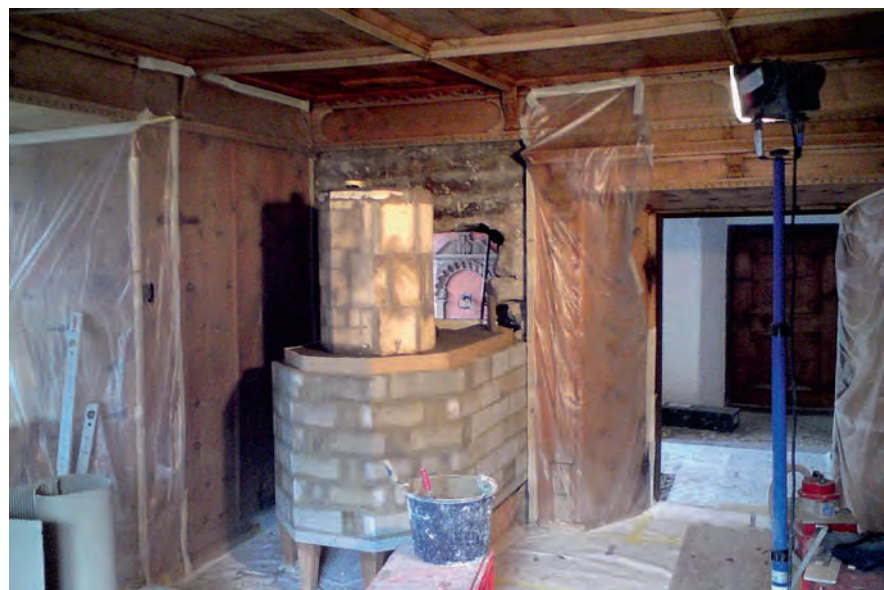
Aufbau des Turmofens im Sprecherhaus in Luzern
